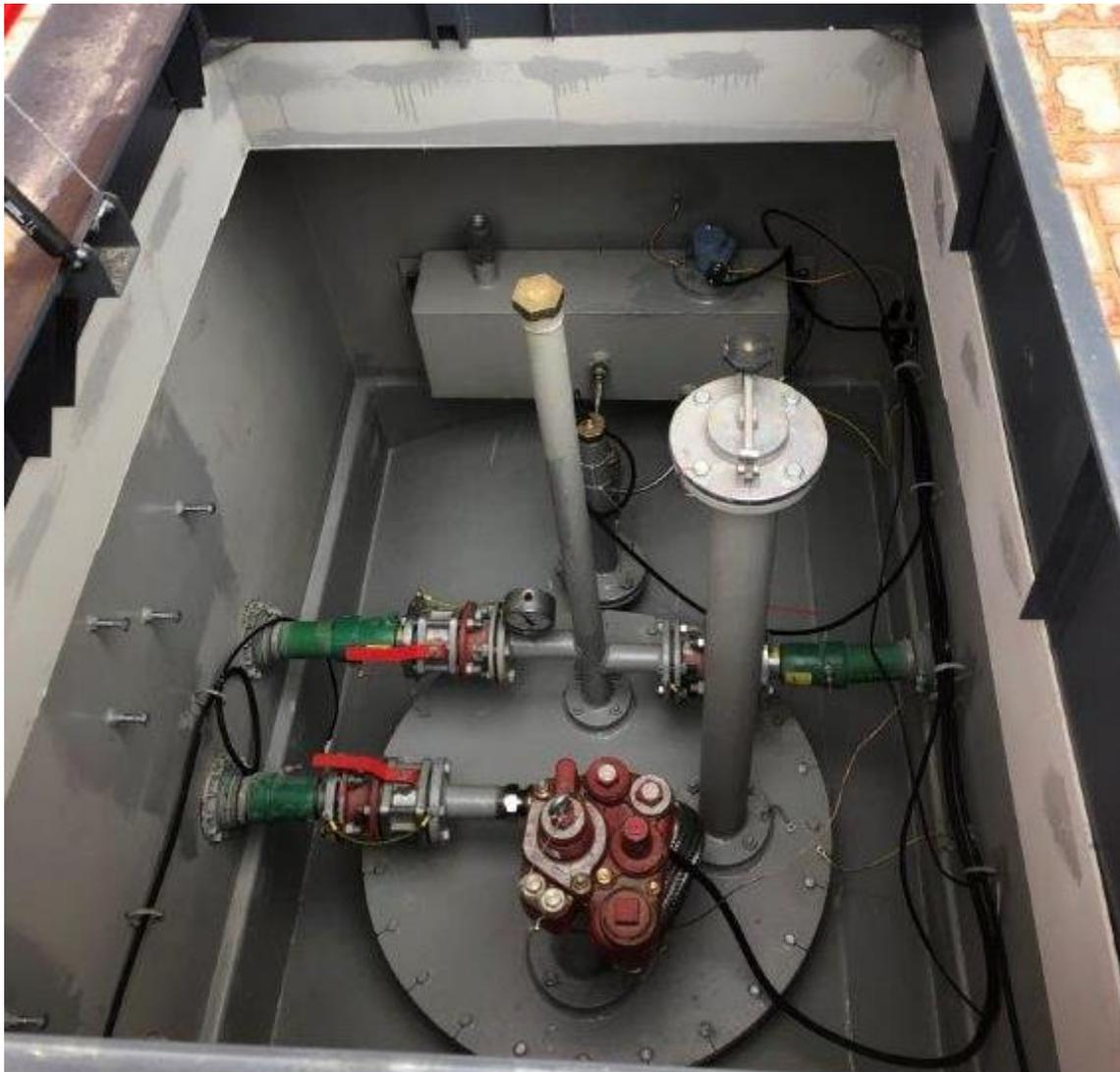
Рис. 1 Фото обвязки резервуара
